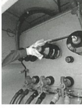
หัวสายและชุด Bushing ด้านแรงสูง
