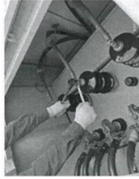
ขั้นตอนการตัดสายไฟฟ้า ด้านบน
