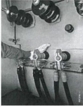
ทำความสะอาด Bushing ด้านล่าง
