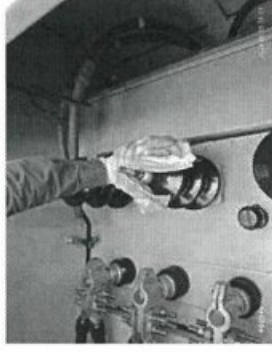
ทำความสะอาด Bushing ด้านบน
