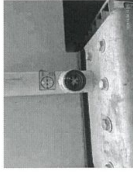
ชื่อระดับน้ำมัน : Oil Level Indicator
