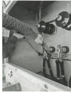
ขันยึดรัดสายไฟด้านเข้า
